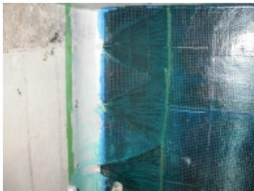
図6 橋桁に取り付けられたCFアンカー
