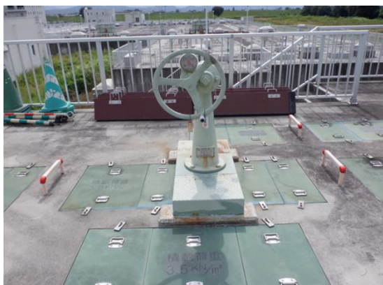
No. 2-1 分配槽ゲート更新（機械）
