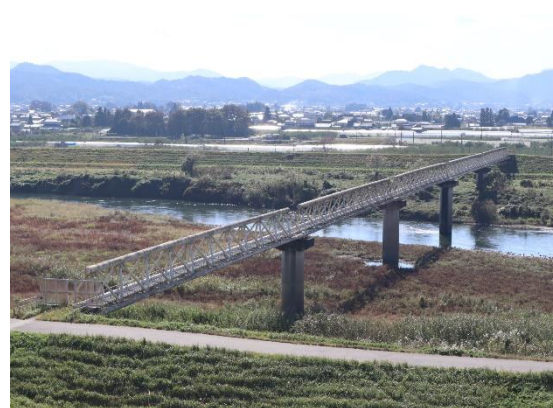
徳江水管橋撤去
