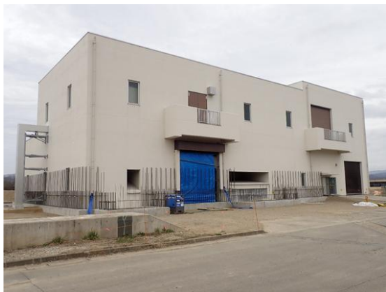
耐水化工事中（第 2SP 棟）
