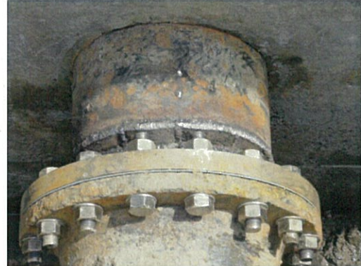
ズレた隙間部分熔接閉
