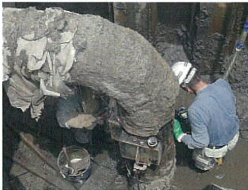
パッチ熔接補修(2箇所)
