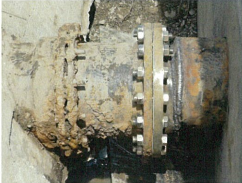
既設フランジ撤去・仮設フランジ取付
