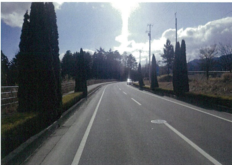
＜相馬工業用水道＞ 市道（復旧完了） ＜終点側から浄水場を望む＞
