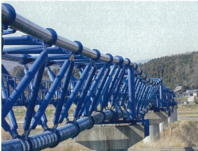
＜沼部水管橋①＞
