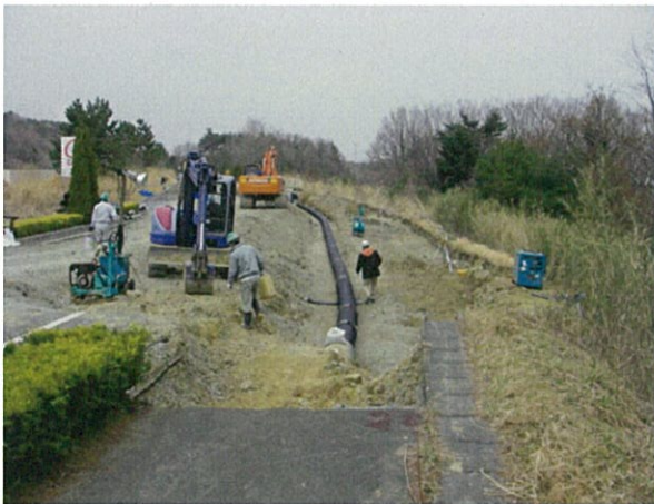
〈仮設管による暫定給水〉
