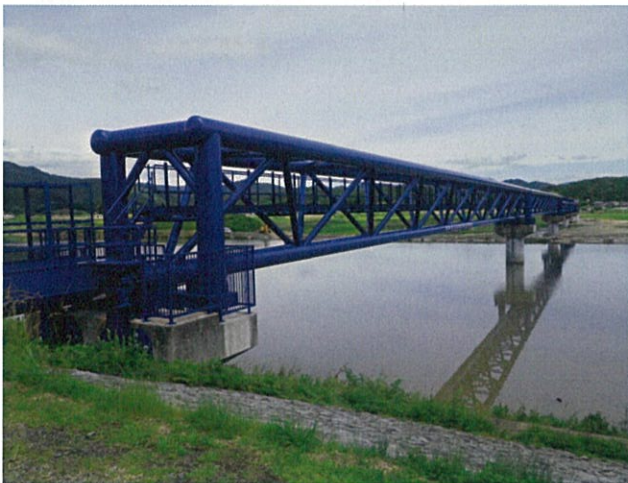
＜災害復旧工事完了＞
