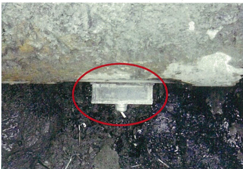
＜磐城工業用水道＞ 配水管（φ 1,100mm） （復旧完了）
