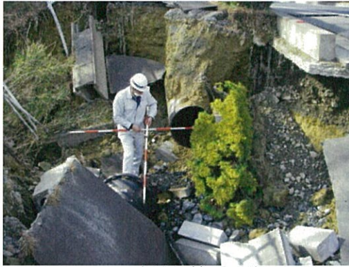
〈配水管破断〉
