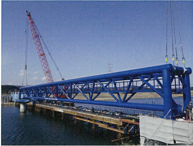
＜上部工架設状況＞
