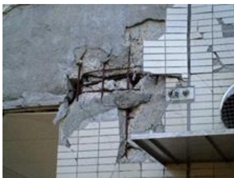
鉄筋爆裂部
