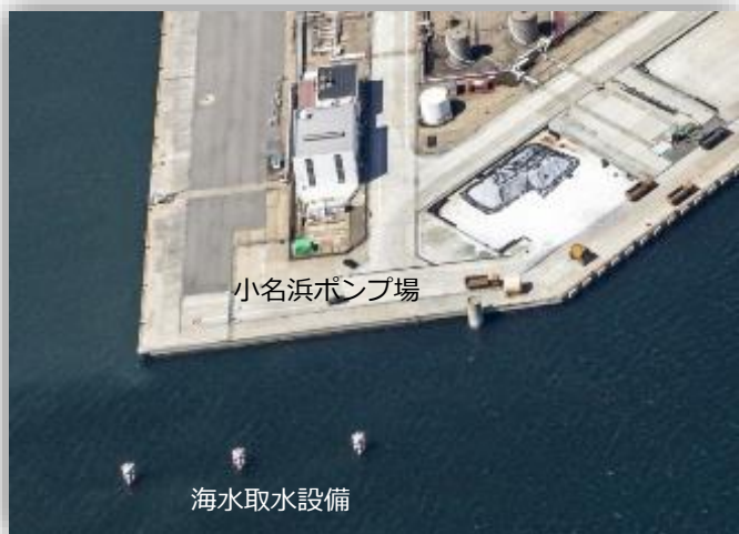
小名浜工業用水道（小名浜ポンプ場）
