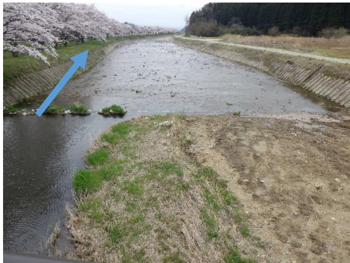
工事後の様子
