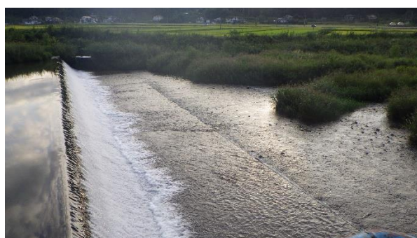
図67 根小屋堰全景
