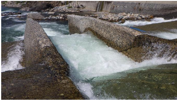
図53 魚道出口の様子
