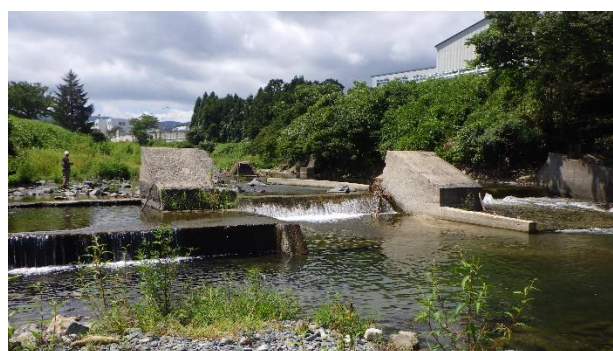
図12 堰堤中央から右岸側の様子
