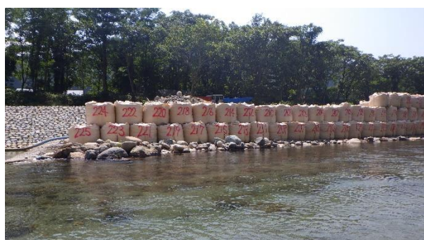
図57 右岸側の工事の様子
