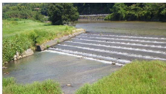
図23 三島堰右岸側の様子
