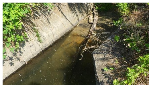
図26 魚道入口の様子
