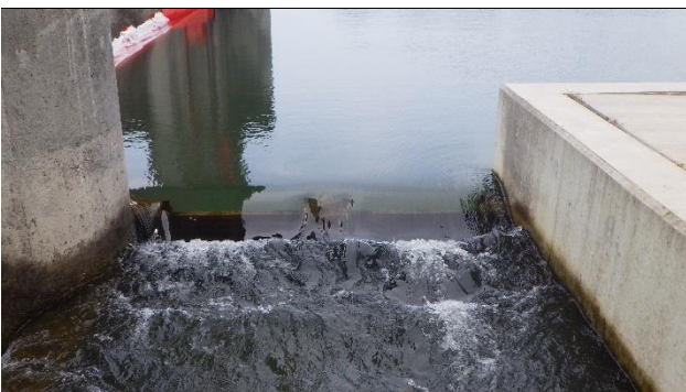
図6 魚道出口の様子
