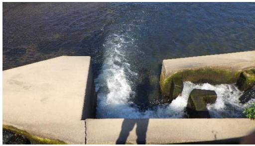
図39 魚道入口の様子
