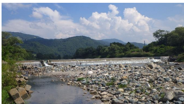
図47 和泉田堰全景
