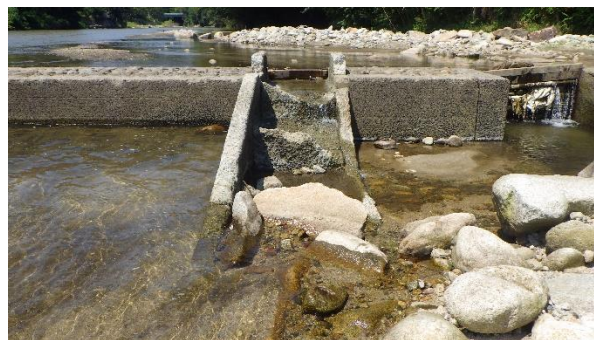
図34 魚道入口の様子
