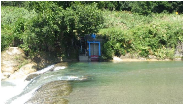
図46 右岸の取水口
