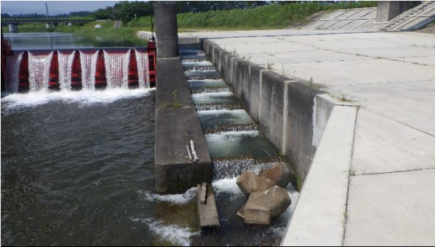
図2 掃部堰頭首工の魚道
