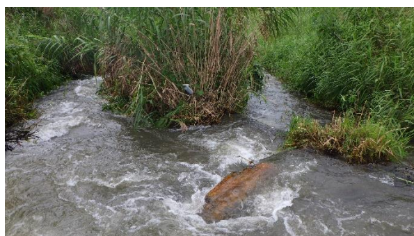
図69 魚道入口の様子
