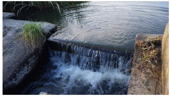
図20 魚道出口の角落とし
