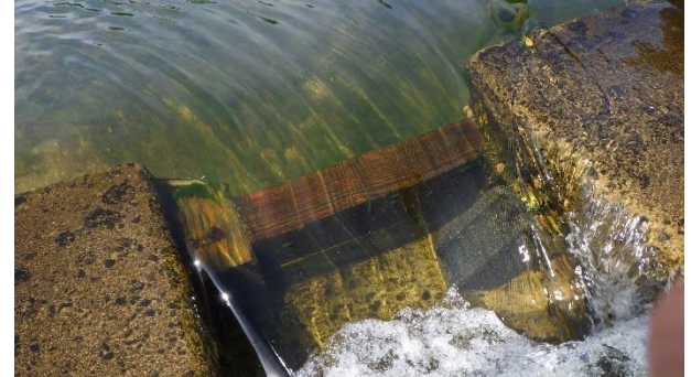
図16 魚道出口の角落とし
