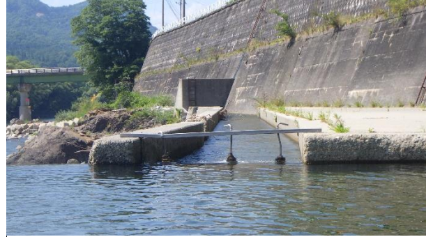
図54 右岸の取水口
