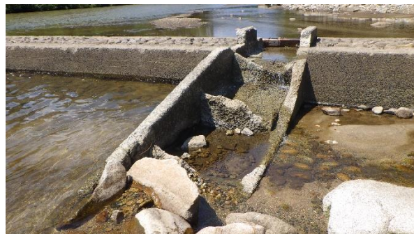
図32 塩田堰の魚道
