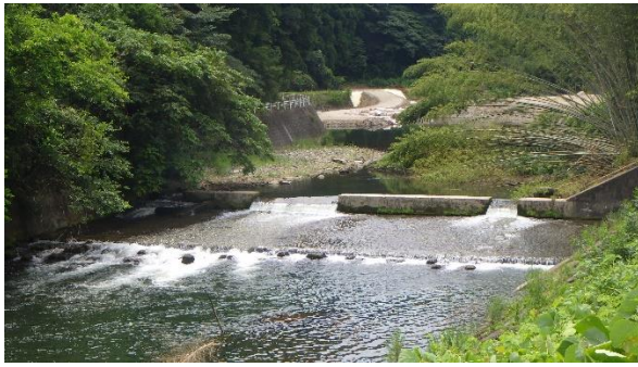
図63 小川橋上流の堰全景
