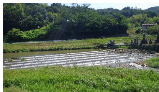
図24 三島堰左岸側の様子
