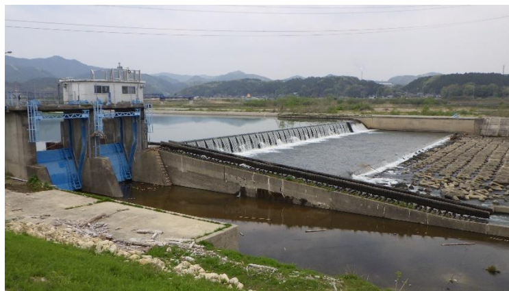
図1 鮫川沼部ポンプ堰
