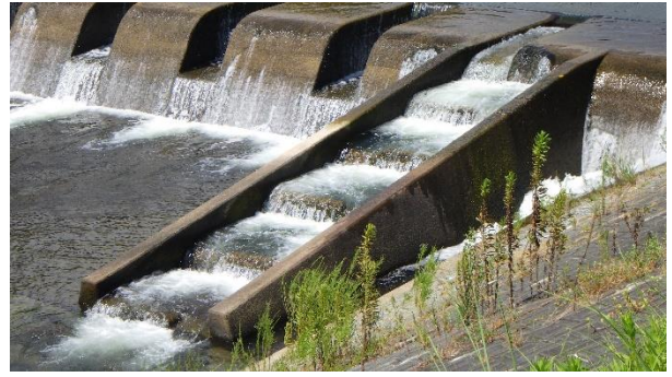
図14 独古内堰の魚道
