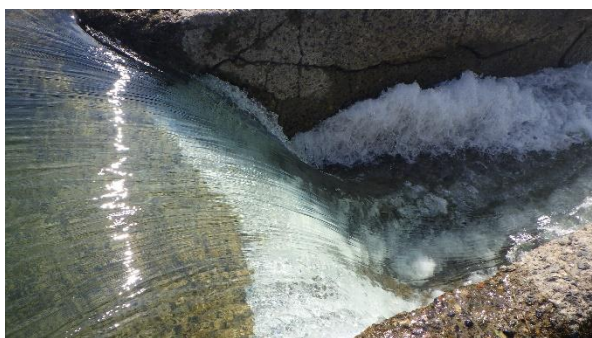
図49 魚道出口の様子
