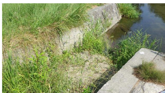
図27 魚道出口の様子
