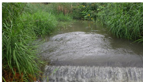
図70 魚道出口の様子
