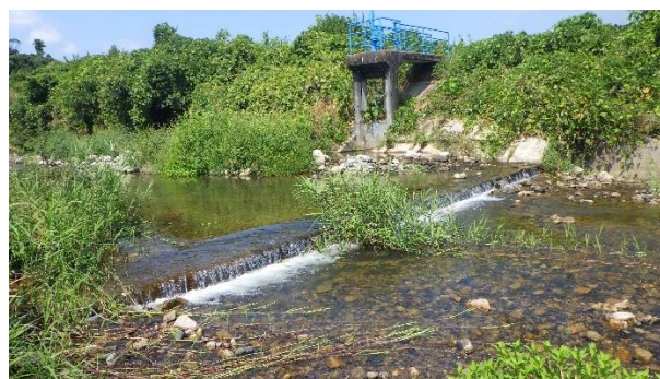
図30 左岸側の様子
