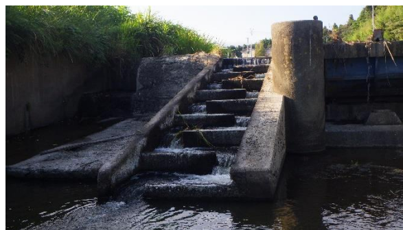
図18 戸田堰の魚道
