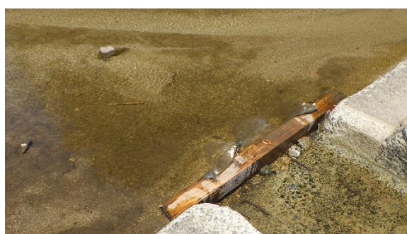
図35 魚道出口の様子
