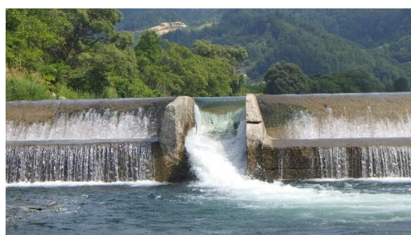
図48 和泉田堰の魚道
