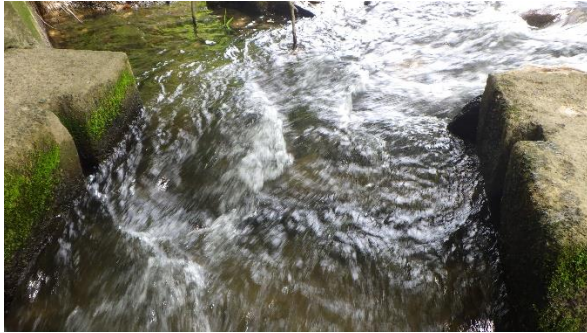
図65 魚道出口の様子
