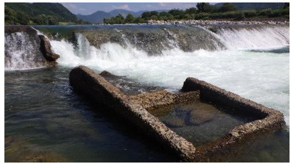
図45 梁取堰の魚道
