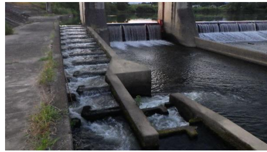
図38 愛谷堰の魚道
