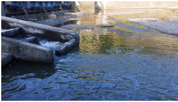
図19 魚道入口の様子
