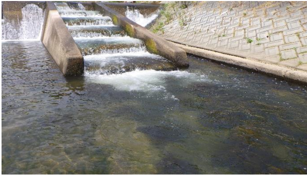
図15 魚道入口の様子
