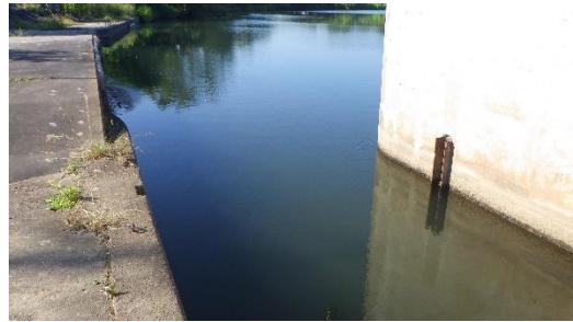
図40 魚道出口の様子
