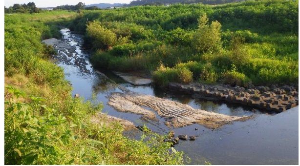
図22 堰堤下流部の状態
