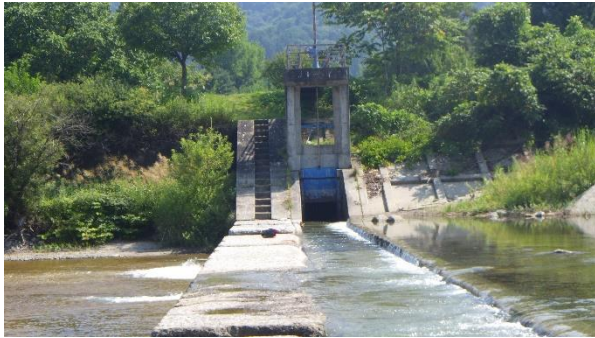
図61 右岸の取水口
