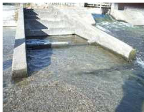
図3 魚道入口の状況
