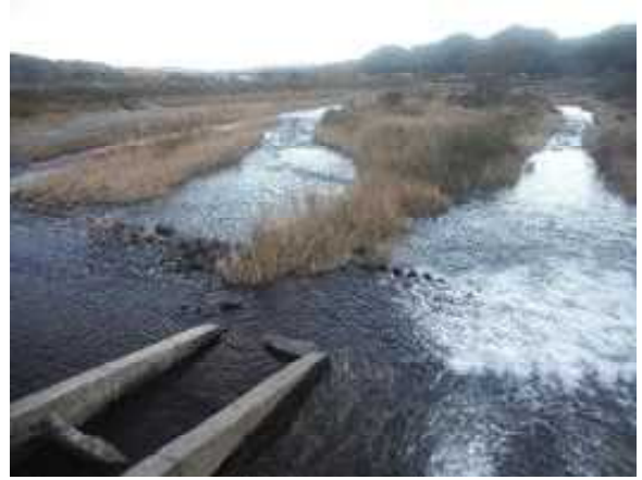
図 10 魚道入口の状況
