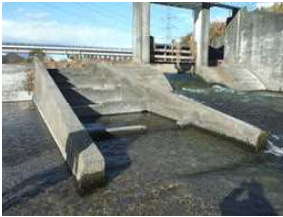
図4 道ヶ作堰の魚道
