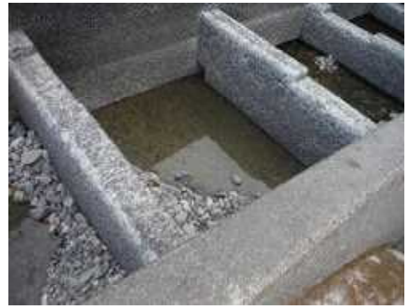
図5 魚道プール内の状況
