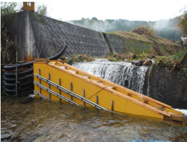
図3 堰に設置された簡易魚道
