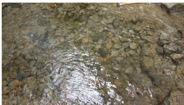
図3 こぶし大の石の敷設
