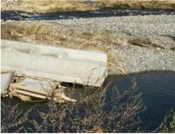
図 24 魚道入口の状況
