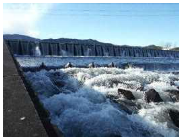
図 30 簡易堰の状況
