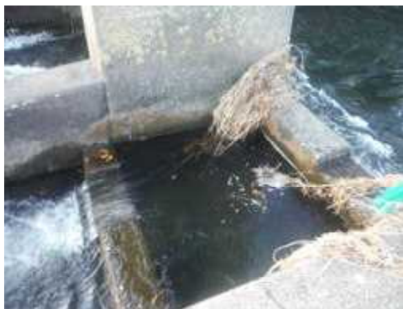
図8 魚道出口の状況
