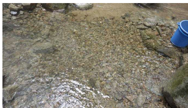
図4 礫止めの設置
