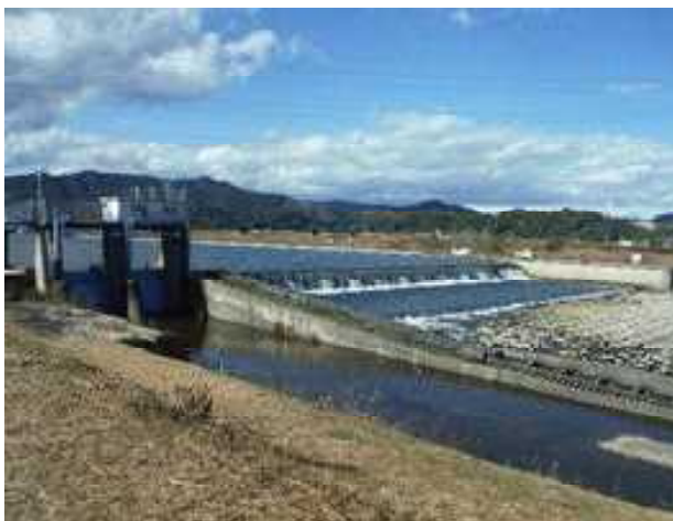
図 29 沼部ポンプ堰
