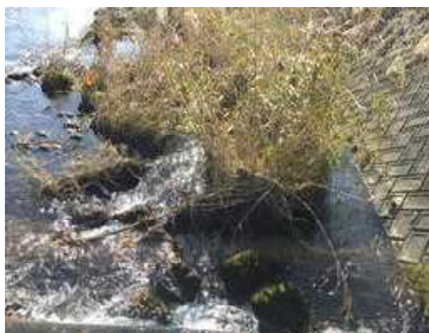
図 17 魚道入口の状況
