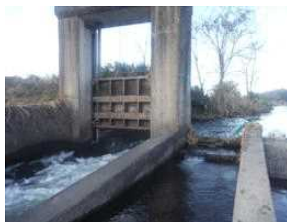
図7 黒助堰の魚道
