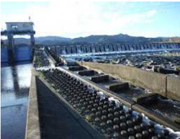
図 33 沼部ポンプ堰の魚道
