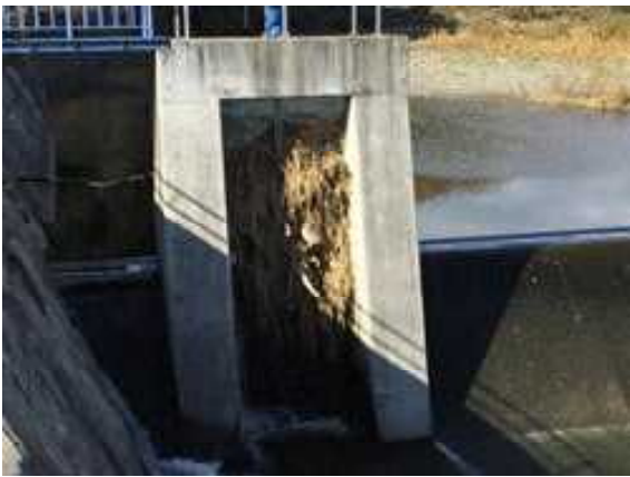
図 26 右岸ゲートの状況
