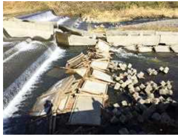
図 23 散乱した護床ブロック
