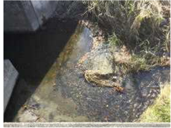
図 20 魚道入口の状況
