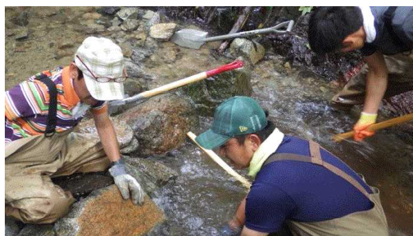
図2 礫止めの設置
