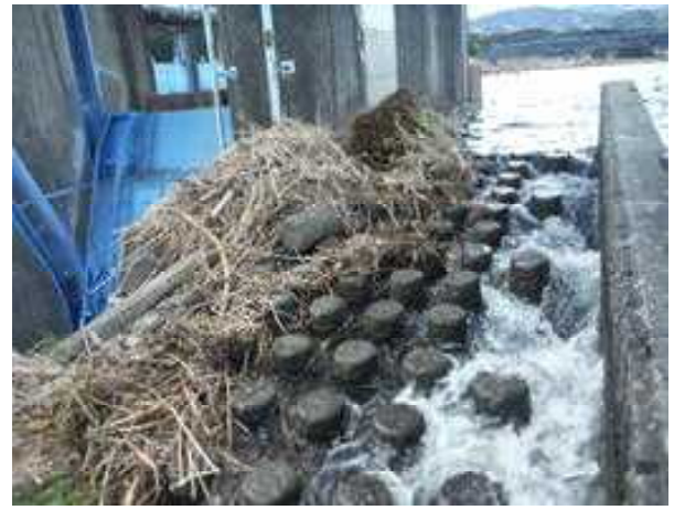
図 32 魚道出口の状況
