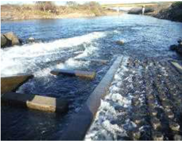
図 31 魚道入口の状況
