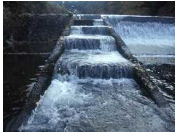
図 15 釜藤堰の魚道
