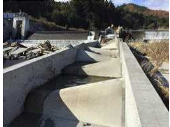
図 25 豊原橋上流の堰の魚道
