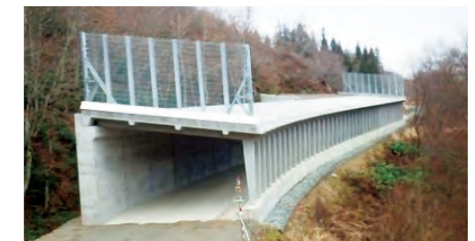
スノーシェッド整備状況 国道289号チバ沢（只見町）
