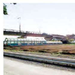
矢吹大橋(矢吹町)
