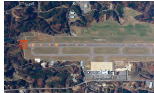
福島空港滑走路端安全区域拡張箇所
