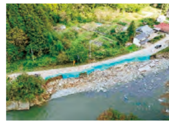
いわき石川線（才鉢）被災状況
