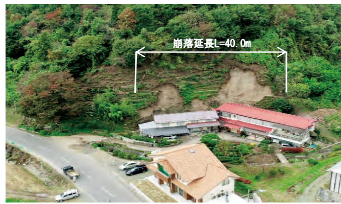
急傾斜地の崩壊
