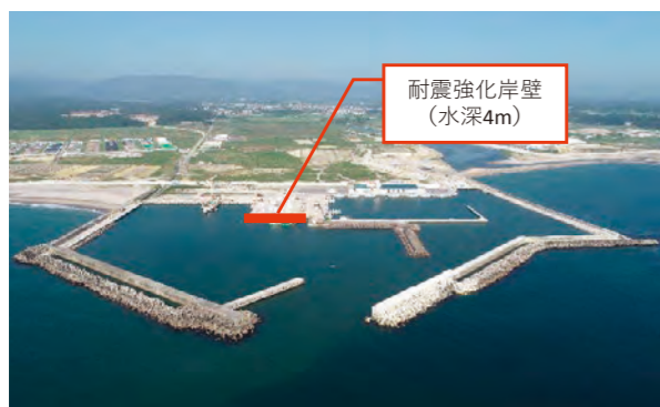
請戸漁港耐震強化岸壁箇所
