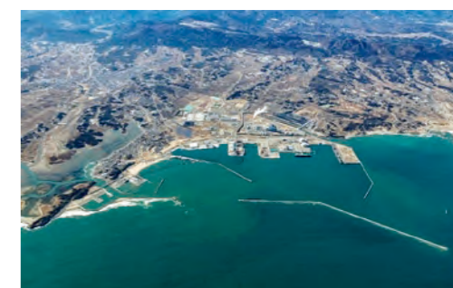
相馬港 防波堤整備 (相馬市、新地町)
