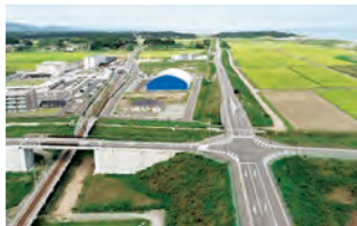
津波被災地復興まちづくりを支援する道路(新地駅周辺)
