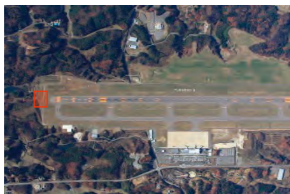
福島空港滑走路端安全区域拡張箇所
