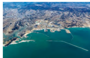
相馬港 防波堤整備 (相馬市、新地町)
