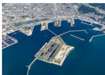
小名浜港東港地区整備状況
