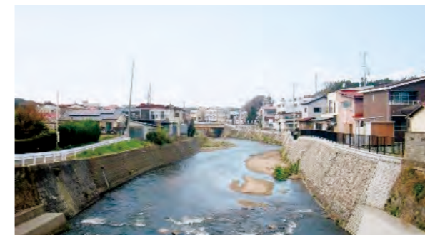
大滝根川 田村市船引町地内の現況
