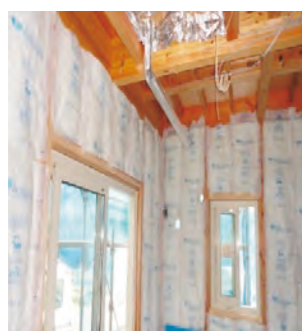
断熱改修の状況
