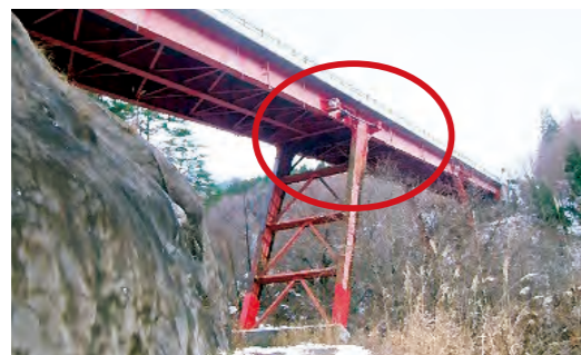
国道289号(南会津町)
