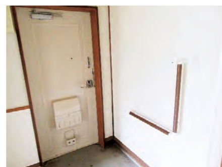
バリアフリー化(手摺設置)した県営住宅
