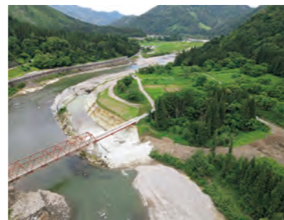
河道掘削の状況 只見川（只見町）
