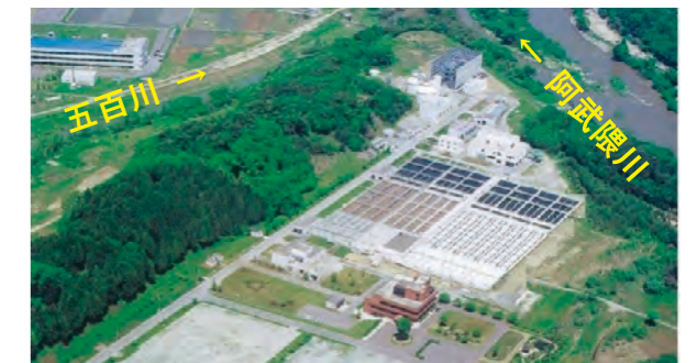
阿武隈川上流流域下水道 県中浄化センター (郡山市)
