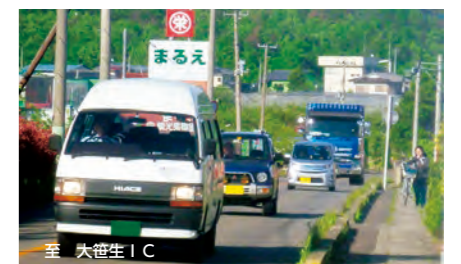
上名倉飯坂伊達線 大笹生2工区現道状況 (福島市)
