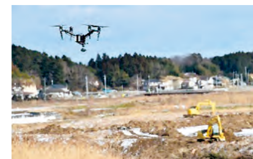
ドローンによる調査
