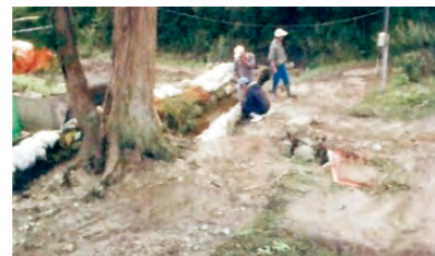
土砂流出の状況
