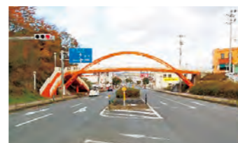
県道小名浜平線 ハツ坂歩道橋（橋梁補修）
