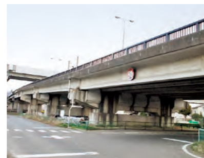
国道115号方木田跨線橋 (福島市)
