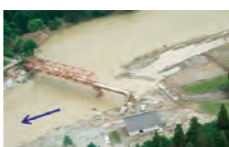
只見川の被災状況
