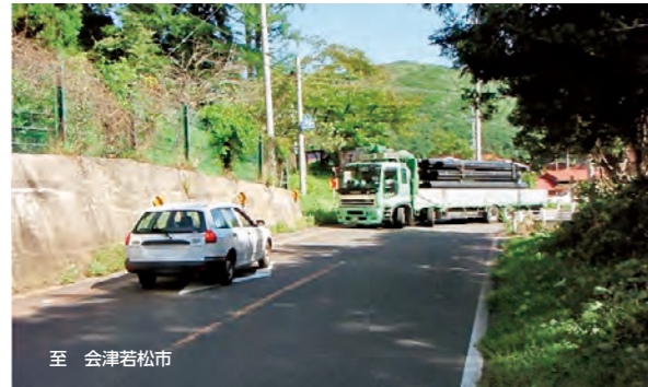
国道294号 福良地内の現道状況
