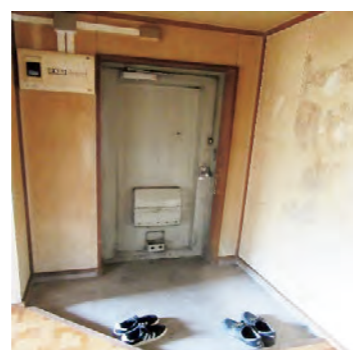
バリアフリー化前の県営住宅
