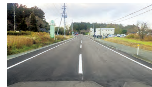
いわき浪江線 舗装補修 (大熊町)
