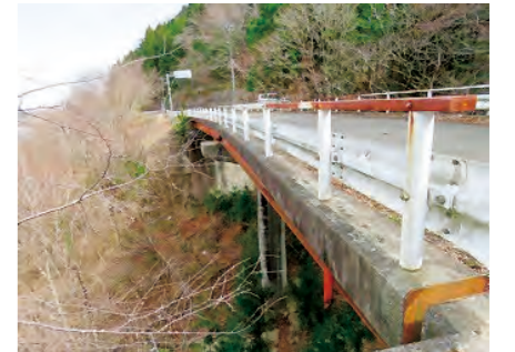
耐震工事予定 原町二本松線(南相馬市)
