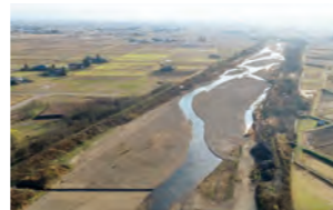
河道掘削状況 濁川（喜多方市）
