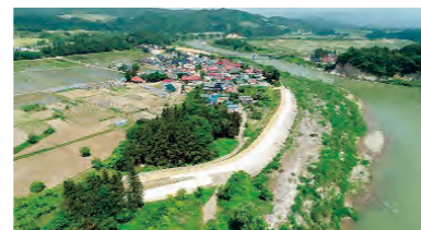
河川堤防の整備状況（只見川）
