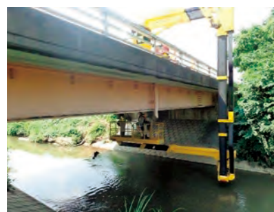
橋梁点検の状況
