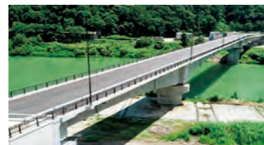
広域ネットワーク道路 国道252号（金山町）
