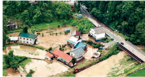
熱塩沢 浸水被害状況
