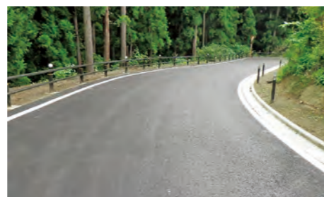
すれ違い困難箇所の解消 藤小槽線(柳津町)
