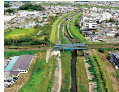
安達太良川河川改修 (本宮市)
