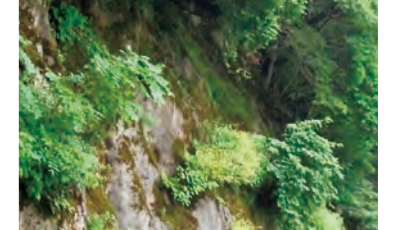
落石対策予定箇所 国道459号 蟹沢乙工区（西会津町）
