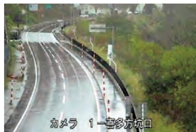
ライブカメラの設置 国道121号（喜多方市）
