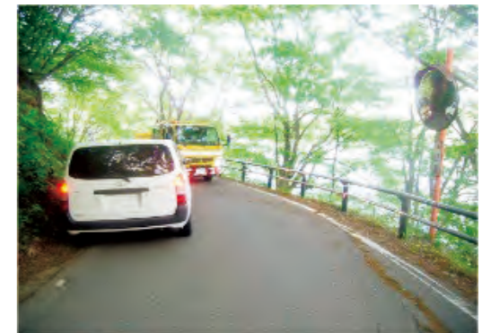
車両のすれ違いが困難な箇所 会津若松裏磐梯線(北塩原村)
