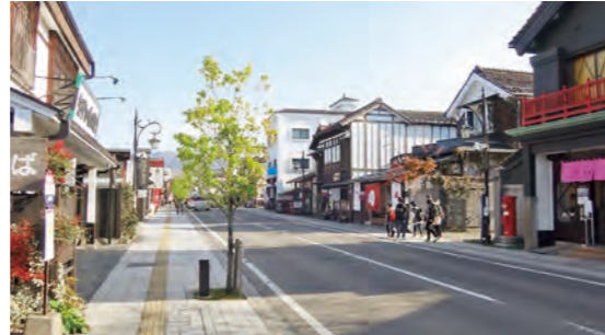
電線類地中化整備後の街並み 国道252号（会津若松市）
