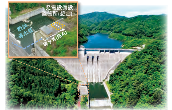
水力発電事業 木戸ダム(檜葉町)
