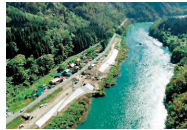
河川堤防の整備状況（只見川）
