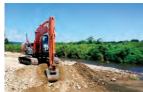
水無川 河道掘削 (南相馬市)
