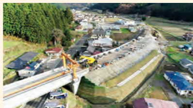
いわき石川線 石川バイパス2工区(石川町)
