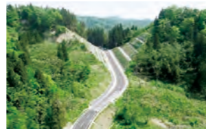
国道459号 藤沢（喜多方市）
