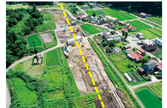
基幹的な道路 会津縦貫道 湯野上バイパス(下郷町)
