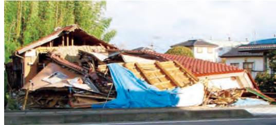
大規模地震により倒壊や被災した住宅
