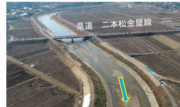
谷田川 (郡山市) 河道掘削状況
