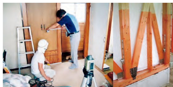
木造住宅の耐震改修の状況
