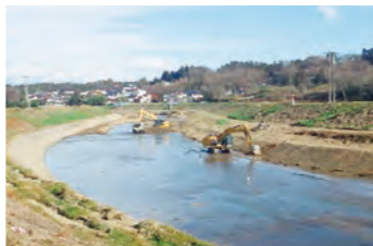
河川の堆砂除去状況
