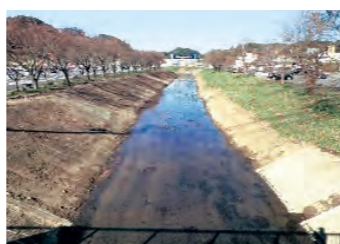
矢田川 河道掘削状況
