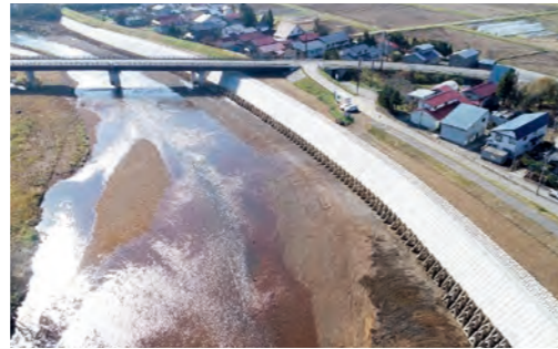
長瀬川整備状況
