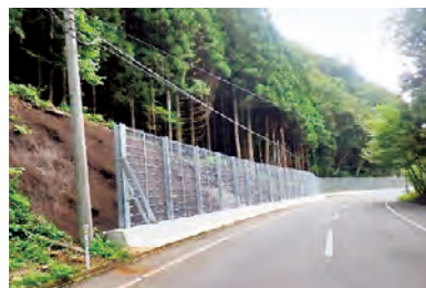
落石対策の状況（浪江三春線 浪江町）
