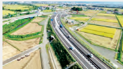
会津縦貫北道路4区(会津若松市)
