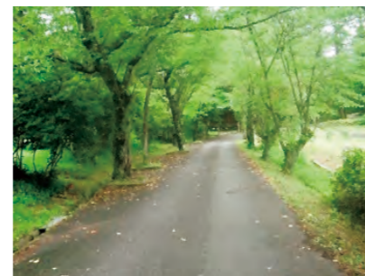
みちのく自転車道
