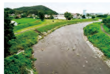
河道掘削により治水安全度を向上 堀川(西郷村)
