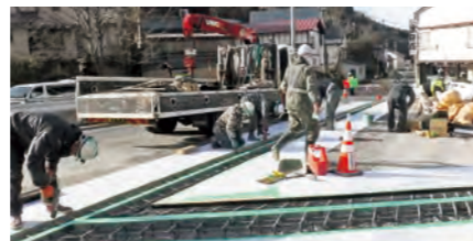
橋梁補修状況 国道459号 高橋橋 (北塩原村)
