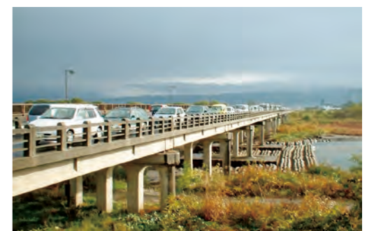
現道の渋滞状況 会津若松三島線 蟹川橋（会津若松市）
