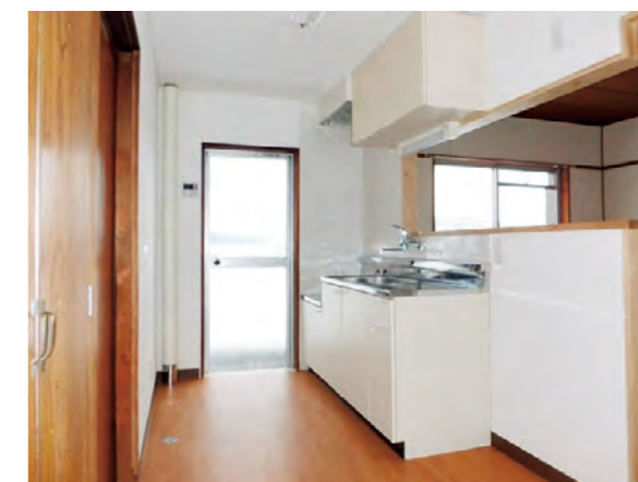
内部改善工事を行った県営住宅
