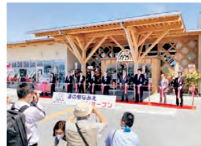
道の駅の整備 道の駅「なみえ」(浪江町)
