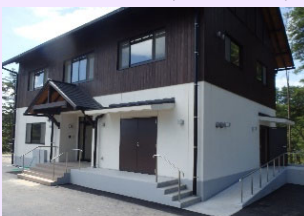
ダム管理棟の新設
