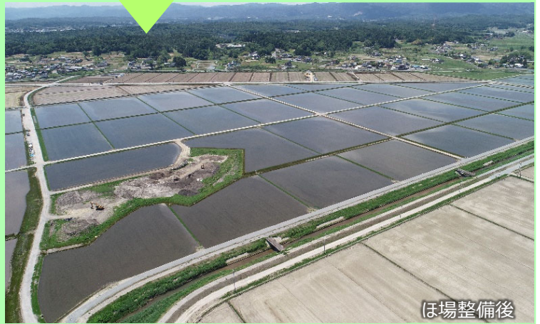
津波による被災状況
