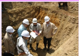
復旧委員会による土質確認
