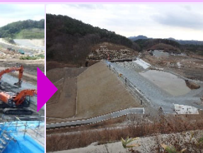
H28.12 本堤盛土完了
