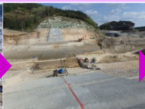
H27.5 本堤掘削完了
