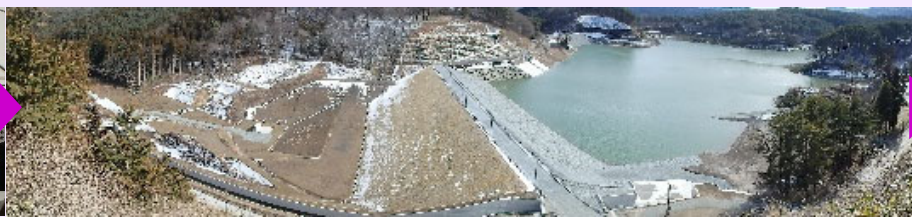
H29.3 湛水試験状況
