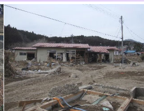
下流家屋の被害
