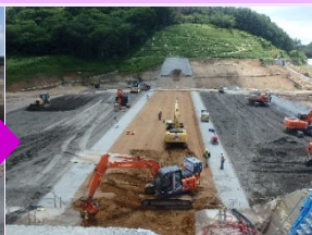
H28.6 本堤盛土状況
