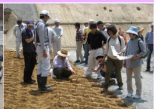
地元説明会(盛土状況)
