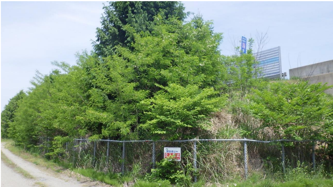
図 1-15 磐越道法面の藪
