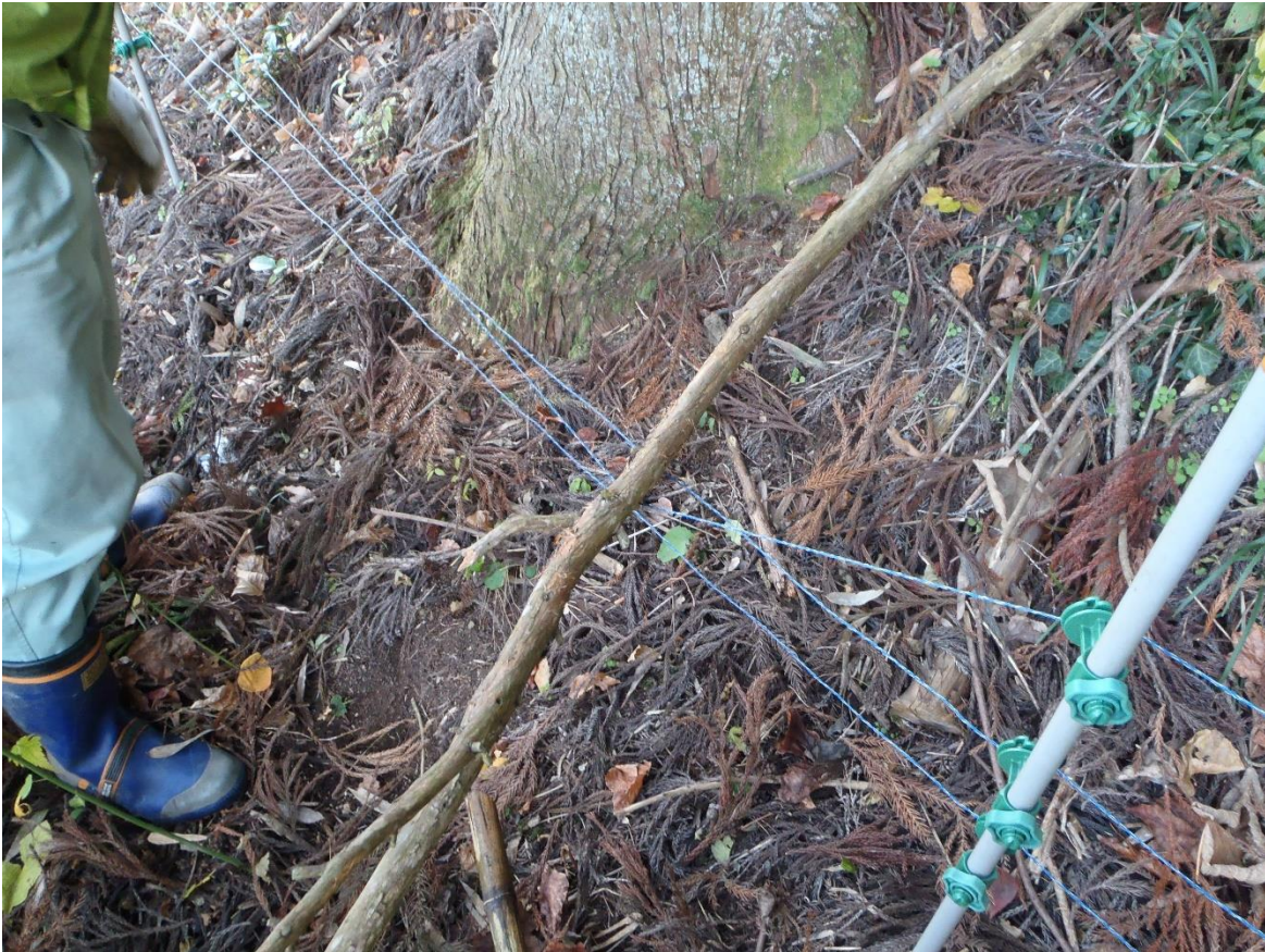
図 2-15 落枝によってよじれてしまった電線
