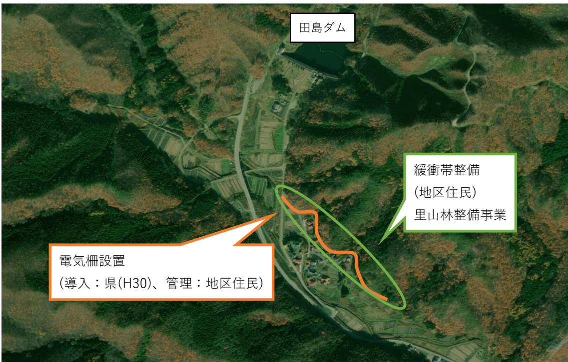
図 1-34 南会津町 高野地区 航空写真
