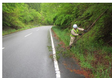
支障木撤去作業
