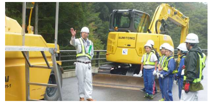
建設現場見学会（R289）10/7 【鮫川小学校】
