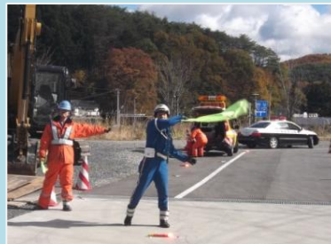
路肩規制の様子
