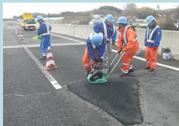
舗装補修状況（平田IC付近）
