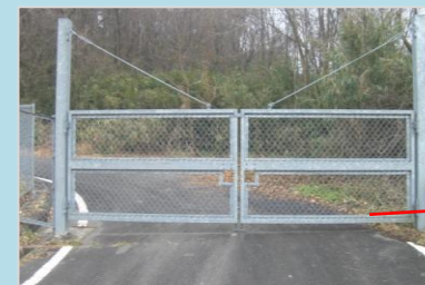
動物侵入防止ネットの設置前
