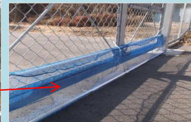
ネット設置完了
