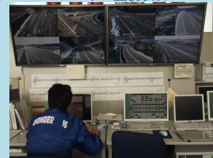
各になどに設置してある10台のカメラからの映像を24時間監視し、道路状況や気象状況を確認します。状況に応じ雪氷作業や緊急パトロールの出動要請、道路情報板の切替えなどを行います。
