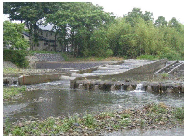
図8 富岡川、門口橋上流の魚道
