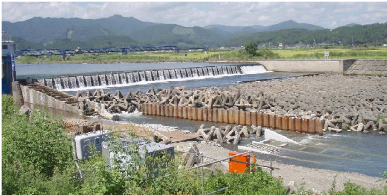
写真2 沼部ポンプ場の改修中の魚道
