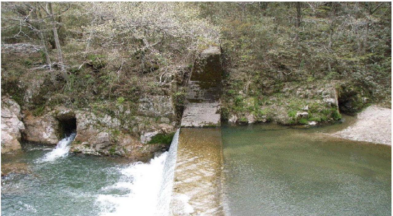
写真1 入北沢砂防堰堤の魚道（全景）
