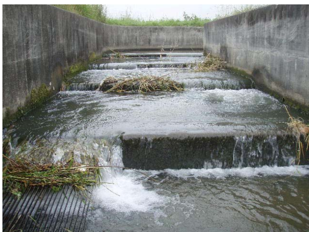
写真2 薬師堂堰右岸魚道
