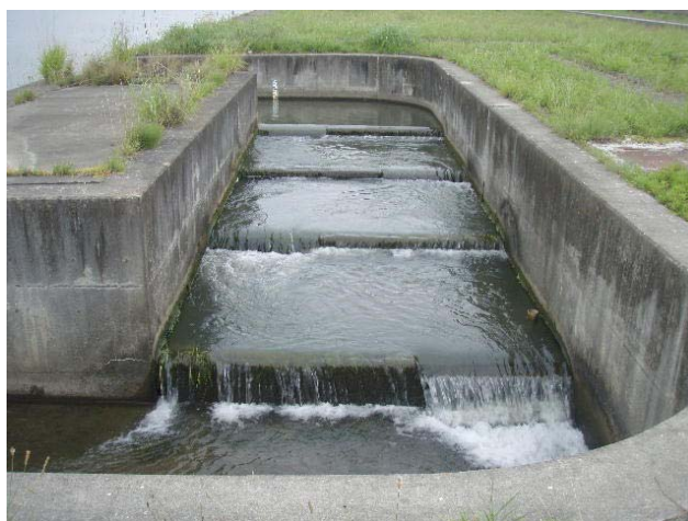
写真3 薬師堂堰左岸魚道
