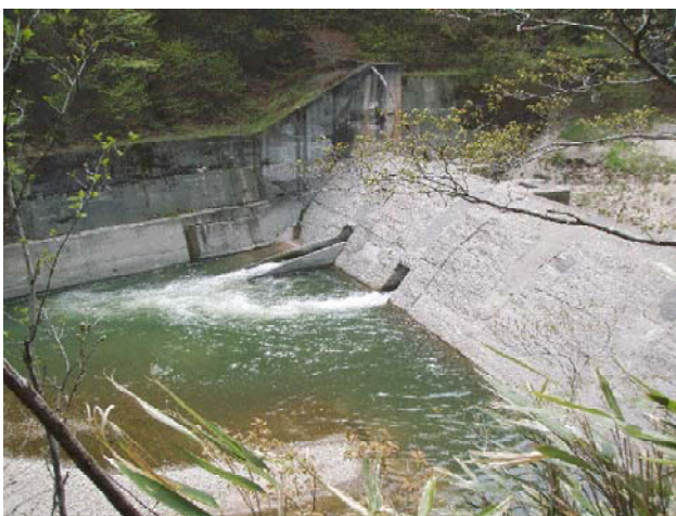
写真6 東北電力の堰堤（下流側）
