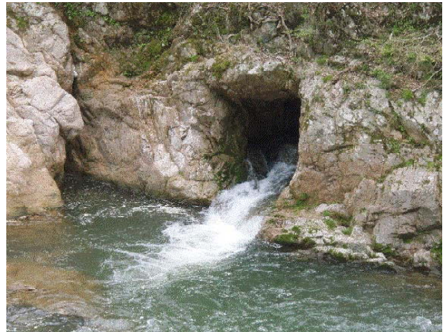
写真5 流木除去後の魚道入口
