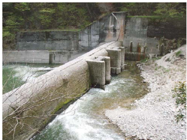
写真7 東北電力の堰堤（上流側）
