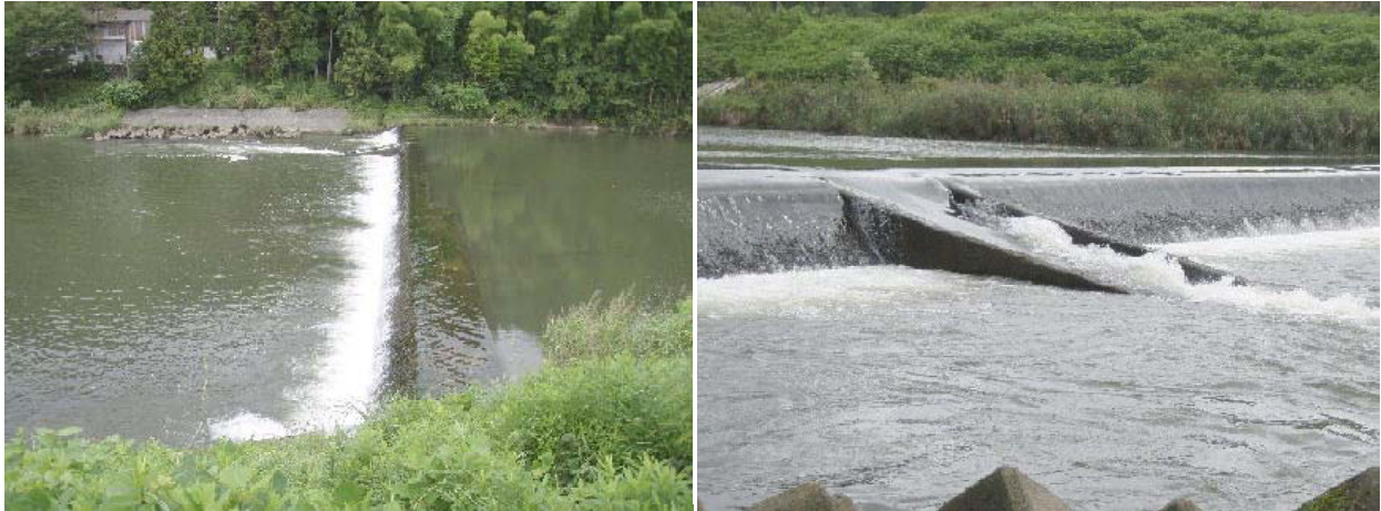
写真3 大谷堰の魚道
