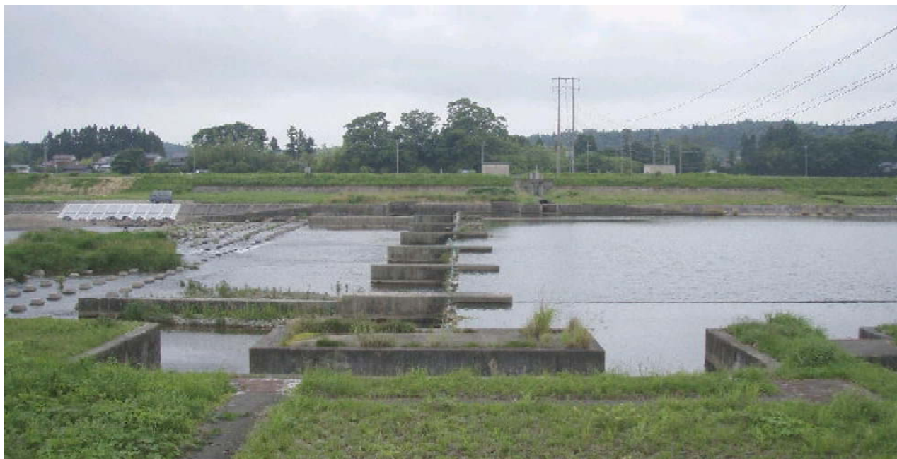
写真1 薬師堂堰全景 (左岸より撮影)
