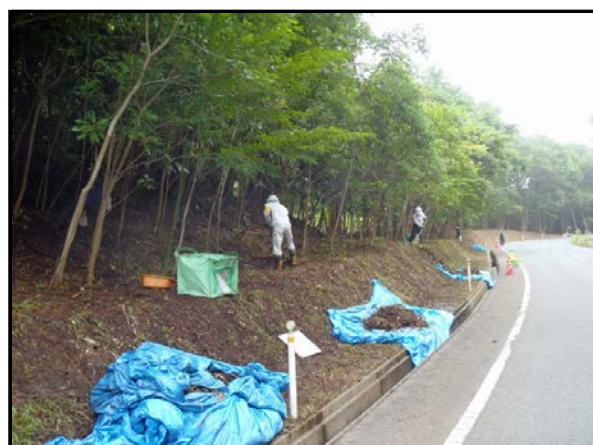
道路路肩除染作業 (H25当時)
