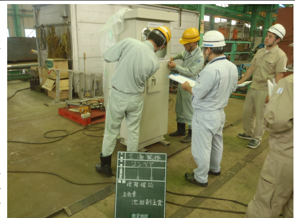
設計通りにできているか厳しくチェック。
