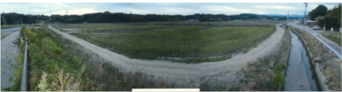
ガレキなどの除去が完了し、現在畦畔の復旧作業を行っています。(平成26年10月26日撮影)
