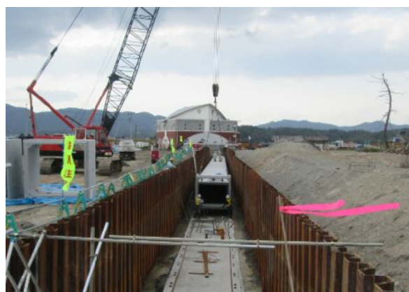
樋管をクローラークレーンで設置中。
