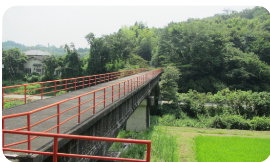
取り入れた水を向かい側の山へ送るため、市道の上を横断している6号水路橋です。
