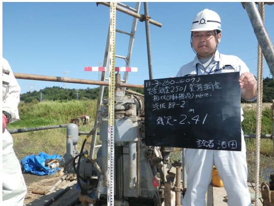
地質調査の現地確認を行う池田さん。
