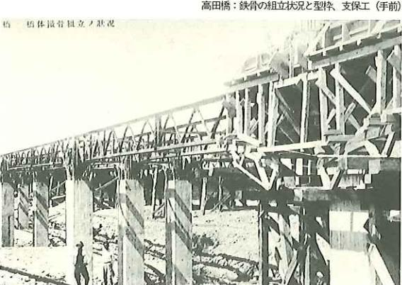
高田橋：鉄骨の組立状況と型枠、支保工（手前）
