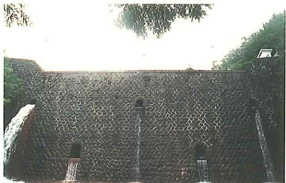
シンメトリーのアーチ型水抜き穴を持つダム(東鴉川第4ダム)
