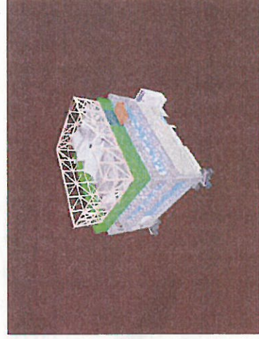
⑥建屋カバー解体完了 ⇒その後、ガシキ撤去作業に移行
