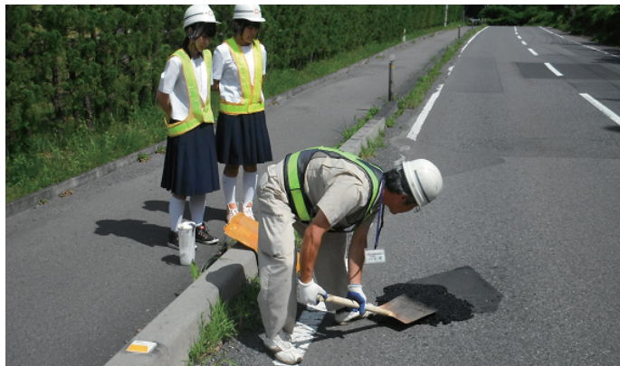
民間パトロール 路面の段差確認
