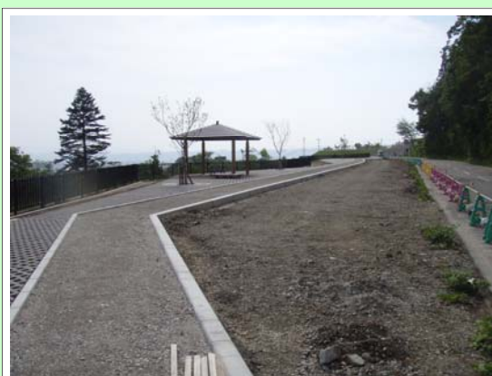
施工中(平成26年度完成予定)
