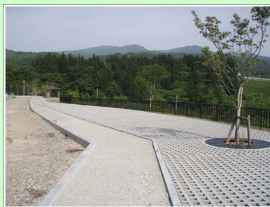
施工中(平成26年度完成予定)
