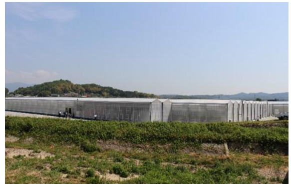
(新設ハウス外観)
