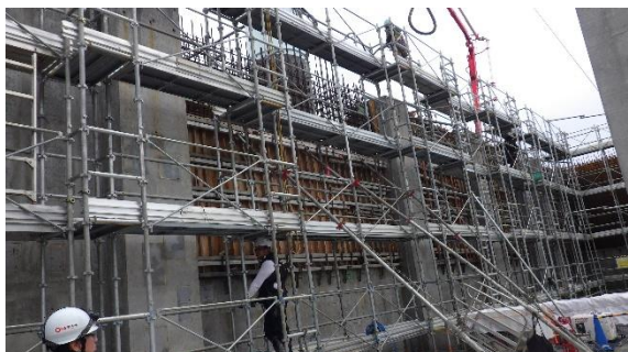
(写真 1 - 3) 2 階壁面のコンクリート打設
