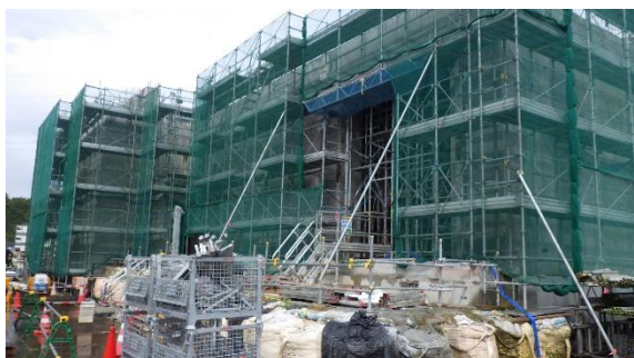
(写真 1 - 1) J A E A 第 2 棟の外観
