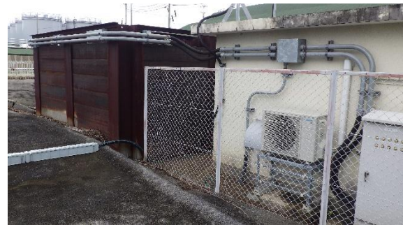
(写真7-1) MP-8の外観
