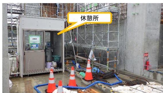
(写真 3) 2 階に設けられた休憩所
