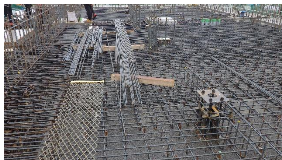
(写真 1 - 2) 2 階床面の配筋
