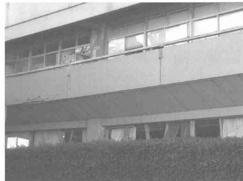
須賀川市役所の外壁
