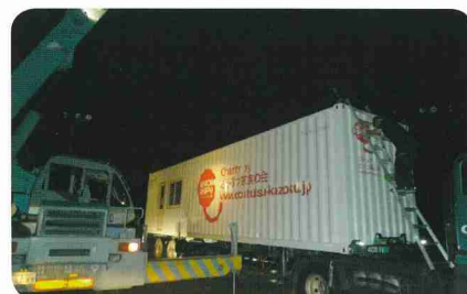
コンテナ設置工事
