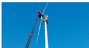
《風力発電》高所作業車による点検状況
