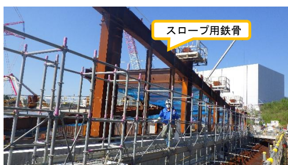
(写真 3－1) 北側搬入口の状況①（運搬車両スロープ用の鋼材組立）
