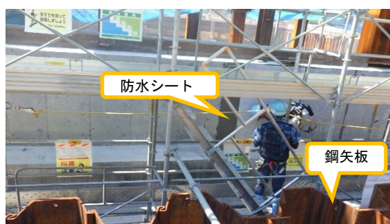
(写真 3－2) 北側搬入口の状況②（壁面への防水シートの貼付作業）
