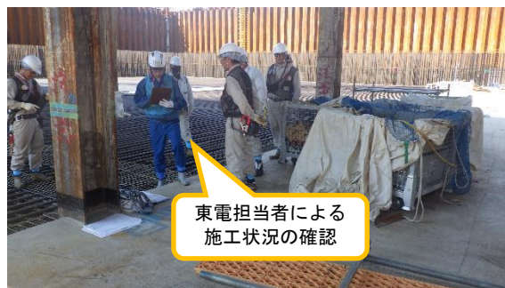
(写真 2－2) 東京電力による施工状況確認②
