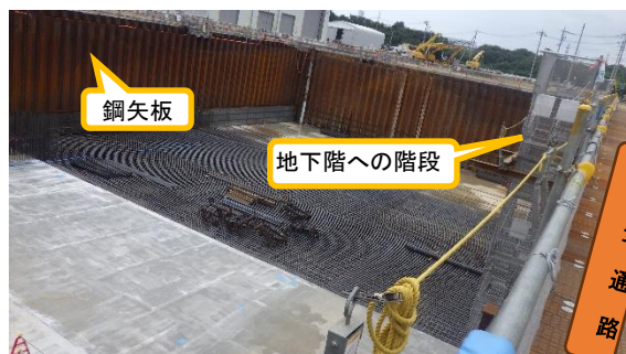
(写真 4－2) 歩廊及び地下階へのアクセスルートの確保状況
