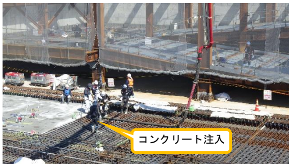
(写真1-3) 地下階のコンクリート打設①(北側スロープの手前部分)
