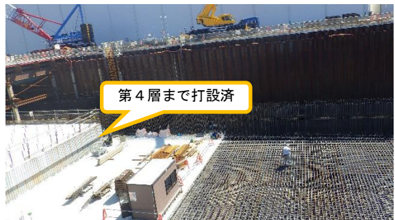
(写真1-4) 地下階のコンクリート打設②(東側、地下階の基礎部分は最大4層での打設構造)
