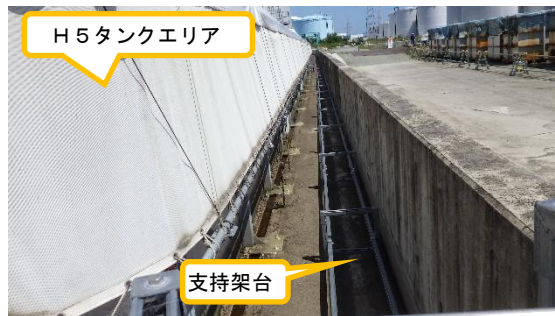
(写真 1 ③) H 5 タンクエリア東側の状況②
