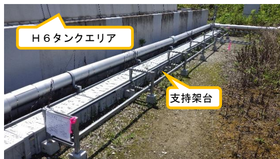
(写真 1 ④) H 6 タンクエリア西側の状況
