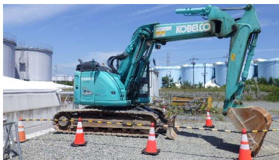
(写真 2) 横断側溝設置工事用のバックホウ
