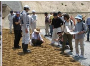
地元説明会（盛土状況）
