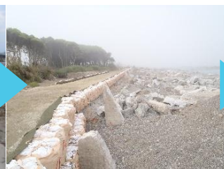
応急工事（仮締切（大型土嚢））
