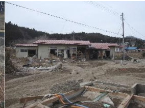
下流家屋の被害
