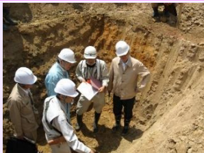
復旧委員会による土質確認
