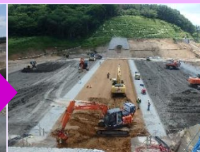
H28.6 本堤盛土状況
