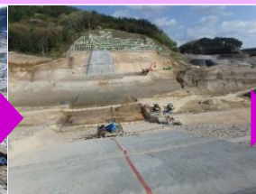
H27.5 本堤掘削完了
