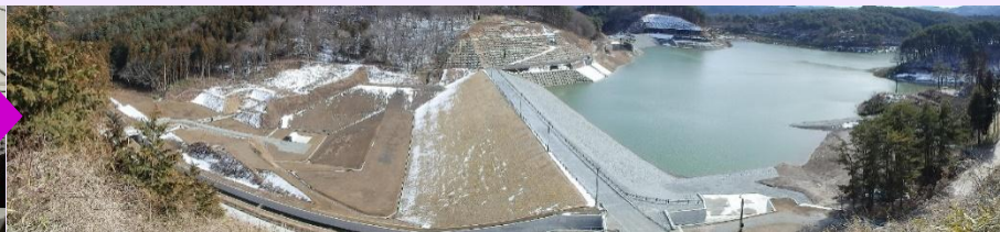
H29.3 湛水試験状況
