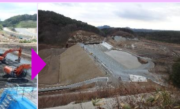
H28.12 本堤盛土完了
