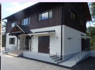
ダム管理棟の新設
