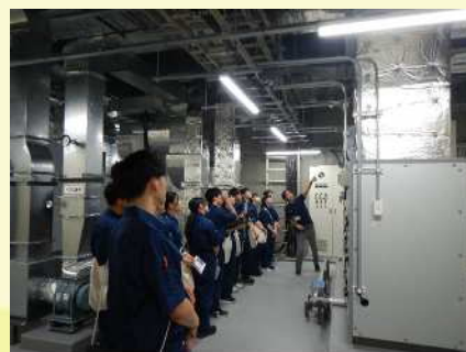
【郡山合同庁舎の設備説明】
