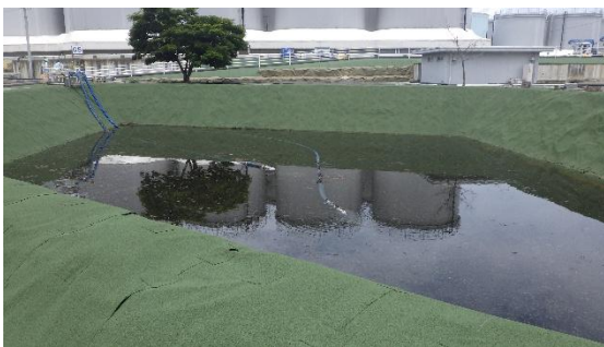
(写真1-1) 雨水構内散水場所
