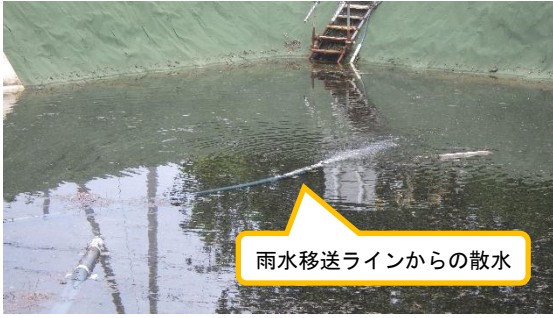
(写真1-3) 雨水構内散水の状況
