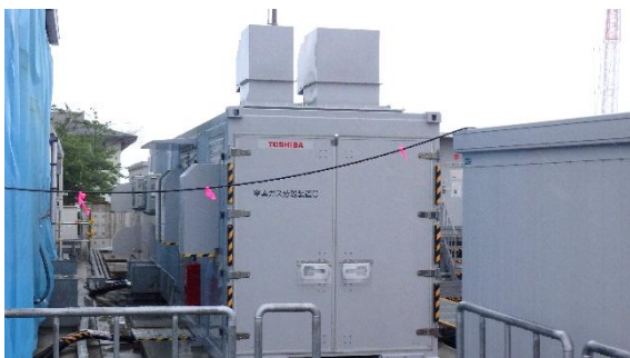
(写真6-1) 更新後の窒素ガス分離装置（C系）
