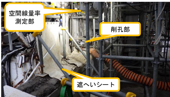
(写真 3) 削孔部の状況
