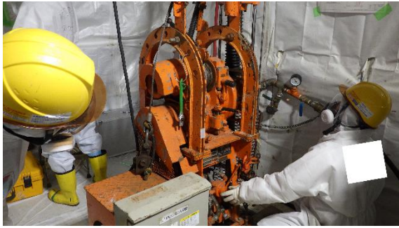
(写真 1 - 2) 作業ハウス内の状況
