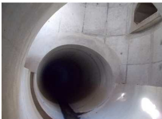
3号幹線増補管の内部（郡山駅前地区）
