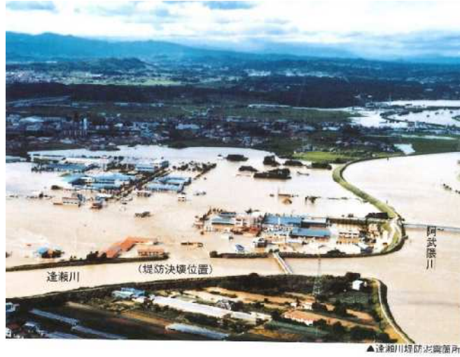
図 1.13 昭和 61 年 8 月洪水（台風第 10 号）の浸水状況 逢瀬川左岸の堤防破堤
