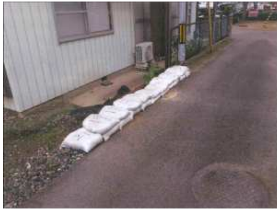
図 13.7 土のうの設置（郡山市）
