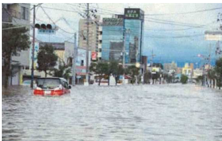
図 1.19 令和元年東日本台風の浸水状況 阿武隈川合流点付近
