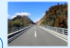
整備中の農道（いわき地区）
