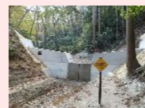
治山施設(五郎兵衛釜地区)
