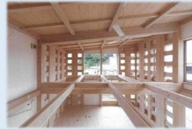
大径材を活用した木造建築物
