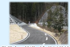
整備中の林道（永井川前線）
