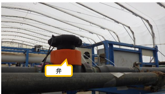
(写真3-2) 更新された弁の設置状況
