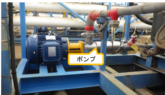
(写真3-1) 更新されたポンプの設置状況
