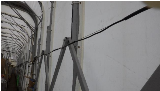
(写真4-2) 更新された建屋カバーの状況② ※骨組みは錆落とし及び再塗装が行われた
