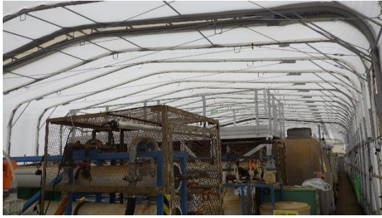
(写真4-1) 更新された建屋カバーの状況①
