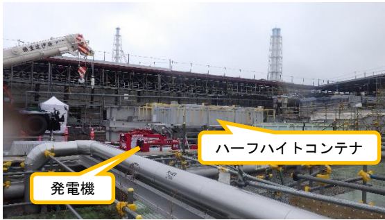
(写真1-2) 資機材の仮置き状況
