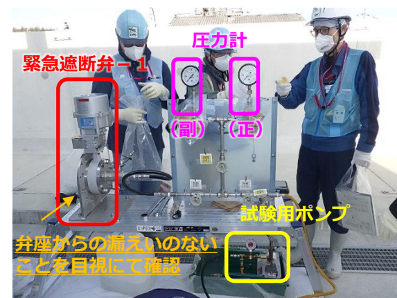
弁座漏えい試験※
