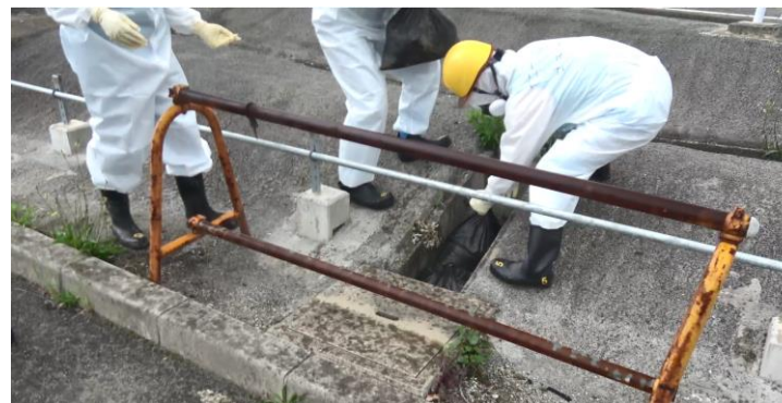
訓練の状況（土嚢設置）
