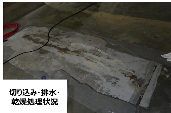
水槽内の膨れ（底面）の補修完了状況
