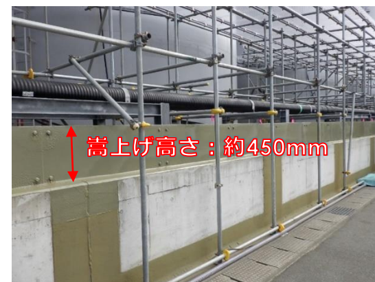
既設外堰嵩上げ状況
