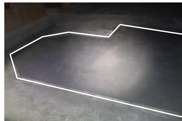
水槽内の膨れ（底面）の補修完了状況
