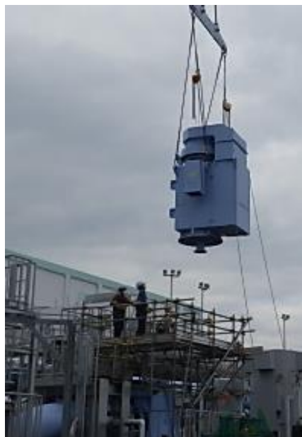
電動機吊上げ
