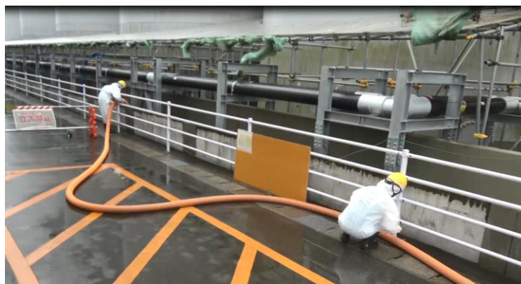
訓練の状況（強力吸引車による回収①）
