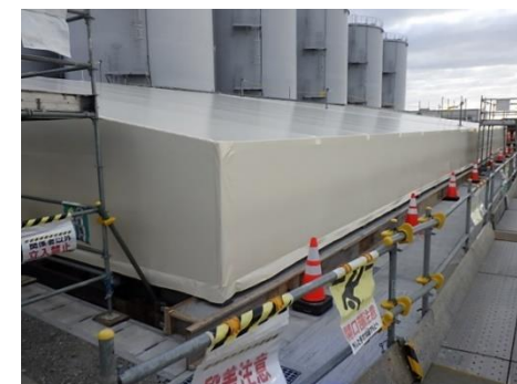
雨水受けカバー設置状況
