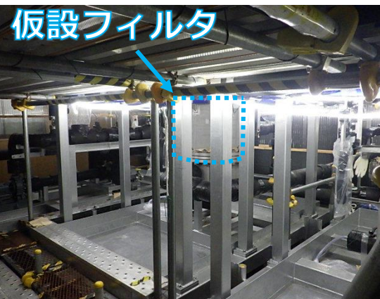
夜間移送作業時の状況②
