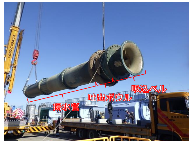
ポンプ吊上げ
