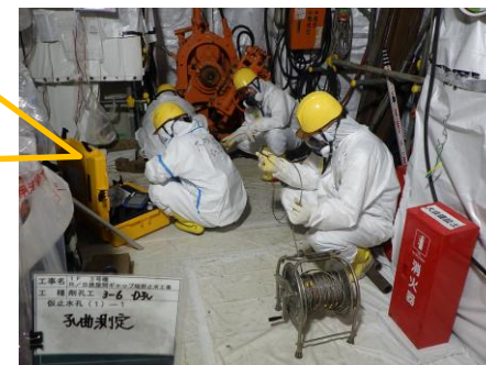
孔曲がり測定状況
