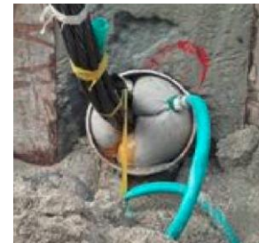
グランドアンカー口元止水
