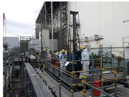
写真1 ボーリング状況
