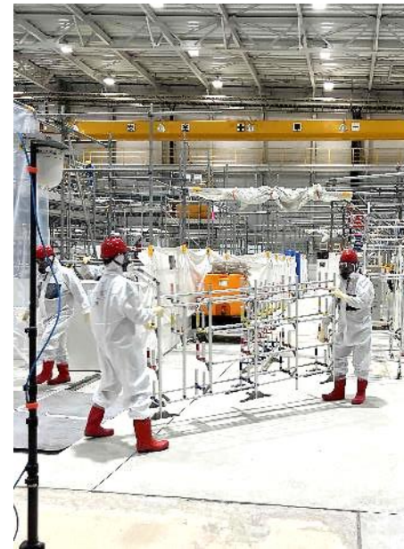
ケーブルラックの設置
