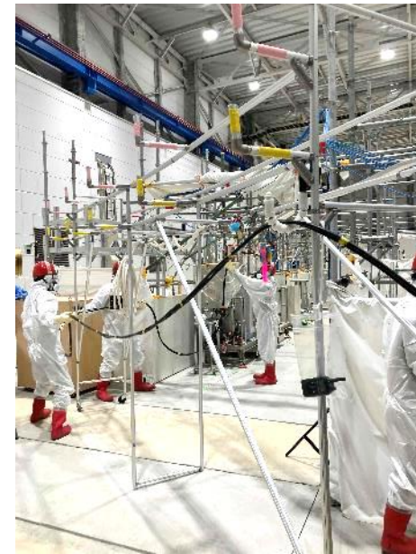
ケーブルの敷設
