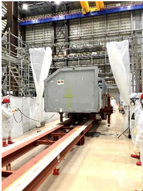
エンクロージャの搬送
