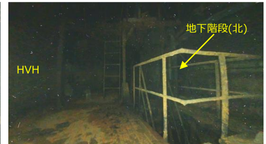
③：ペDESTAL外 北エリア
