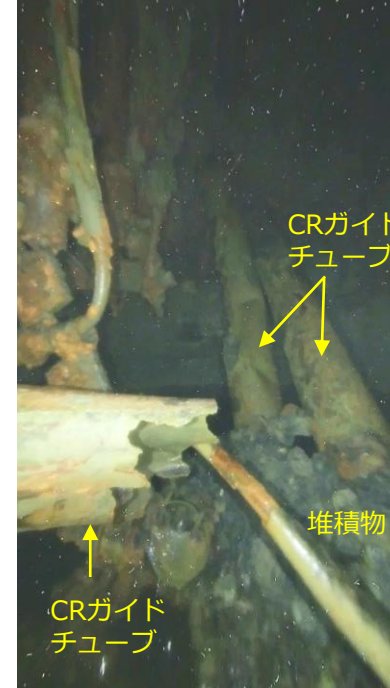
②：落下している構造物
