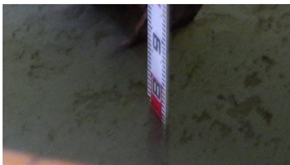
(写真1-2) 5号機タービン建屋地下階の水位
