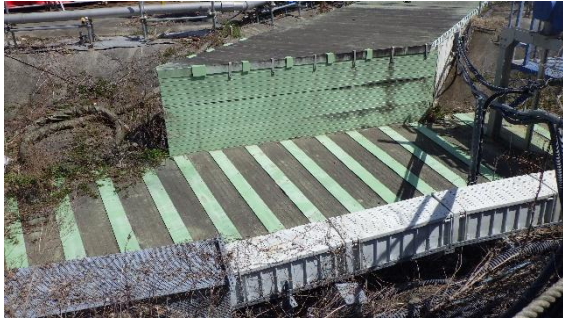
(写真1-3) BC排水路の状況
