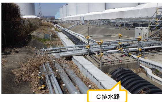
(写真1-2) C排水路の状況
