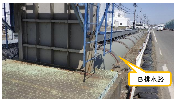
(写真1-1) B排水路の状況
