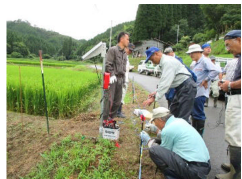
地域ぐるみでの電気柵設置作業 （白河市）
