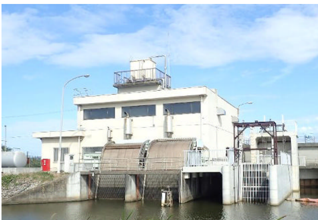
おおごえふじま 大越藤間第二排水機場（いわき市）
