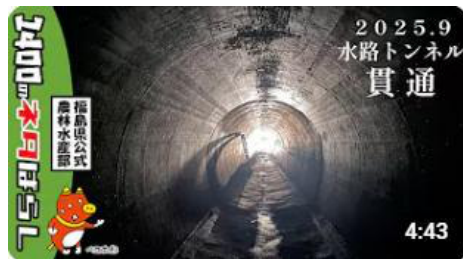
水路トンネル、ついに貫通
