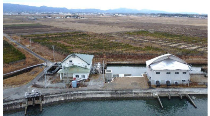
写真右：相馬排水機場（相馬市）
