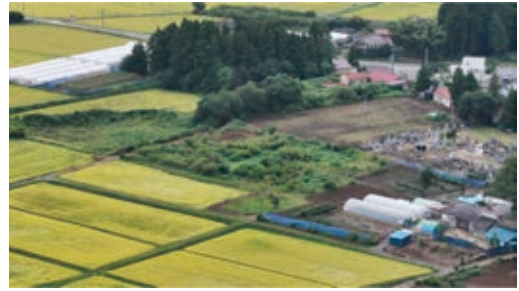
写真6 ドローンで撮影した画像
