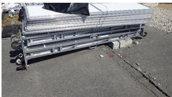
(写真1③) 撤去された仮囲い
