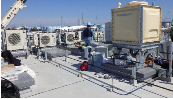
(写真2) 空調機器等の設置作業
