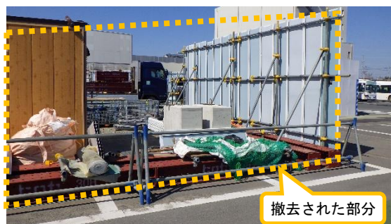
(写真1②) 仮囲いの撤去状況
