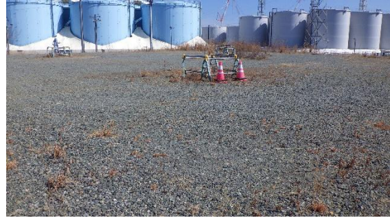
(写真3①) 地下貯水槽No. 6の地上部の状況
