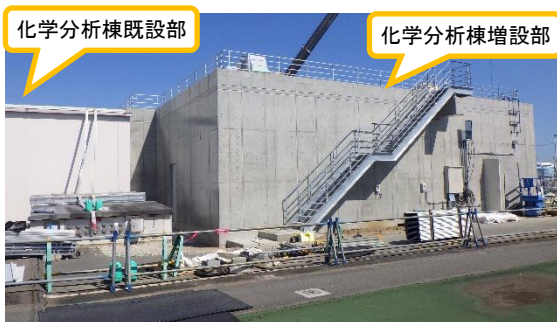
(写真1①) 化学分析棟増設部
