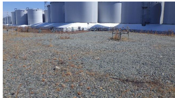
(写真4①) 地下貯水槽No. 7の地上部の状況
