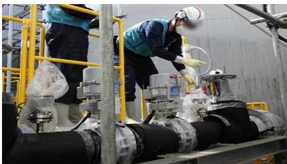
(写真1) 指差呼称による弁の開閉確認の実施状況
