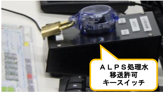
(写真6-1)ALPS処理水海洋放出開始前の移送許可キースイッチの状況
