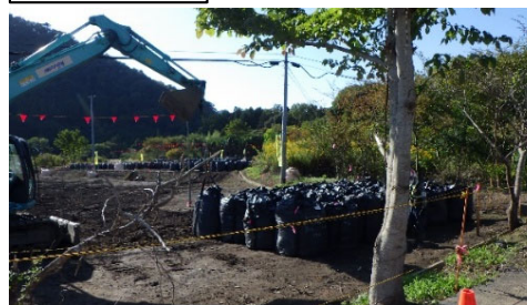
積込作業（除染工事現場）
