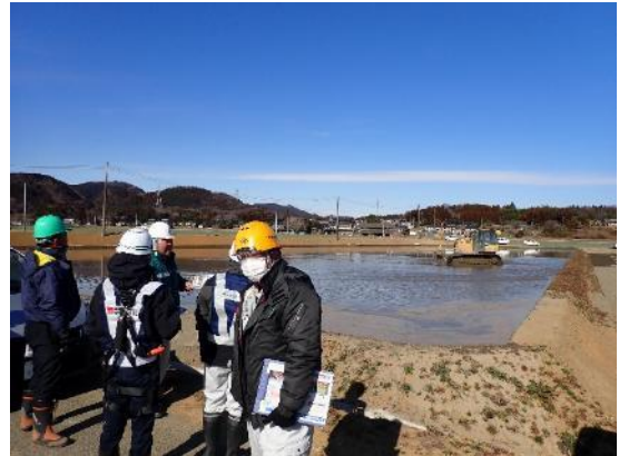
▲管内現場（区画整理工）
