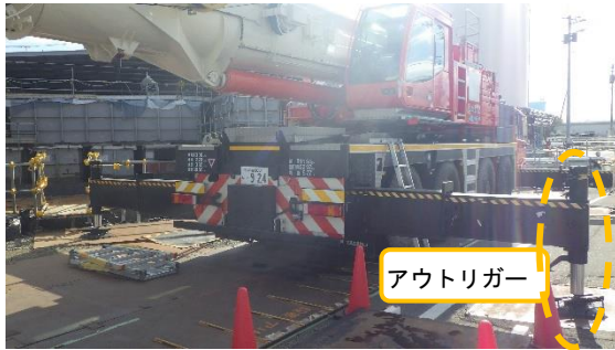
(写真 4 ③) 100 t クレーン車の設置状況①
