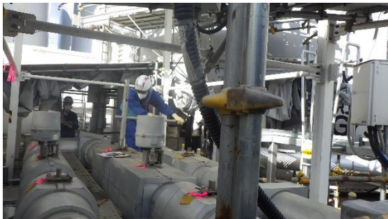
(写真2) 排水弁の全開作業
