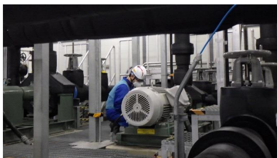
(写真 6) ポンプ起動後の確認状況
