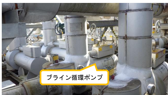
(写真 4 - 2) ブライン循環ポンプの設置状況
