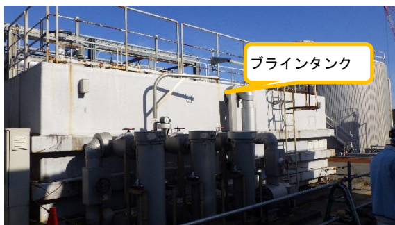
(写真 4 - 1) ブラインタンク設置状況
